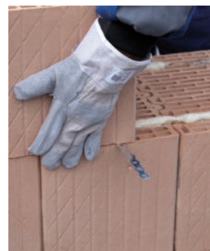
20. Umiestnenie tvárnice pri spojení stenovej spony
