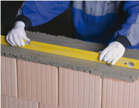
4. Murovacou maltou vytvorená vrstva
