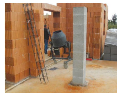
11. Stĺpové debnenie a vystuženie
