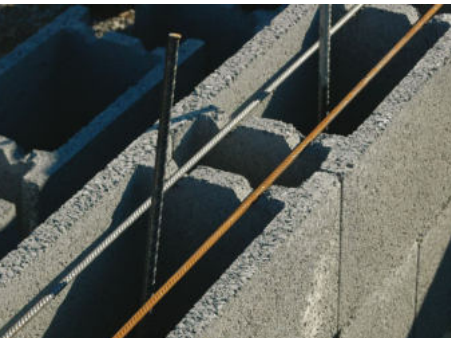
7. Zvislé a vodorovné armovanie pred betónovaním
