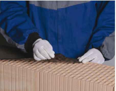
18. Uzavretie konštrukcie steny bitúmenovou izolačnou doskou
