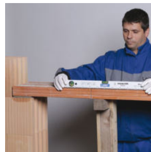
49. Kontrola vodorovnej polohy
