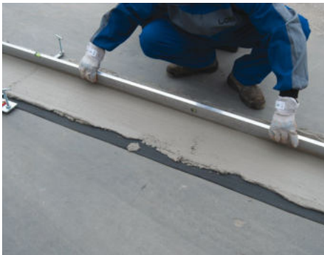
8. Vytvorenie maltového pásu pod prvým radom
