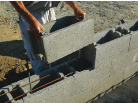
6. Prvky usporiadané do väzieb
