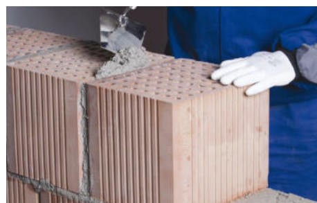
36. Protihluková stena zvislá medzera
