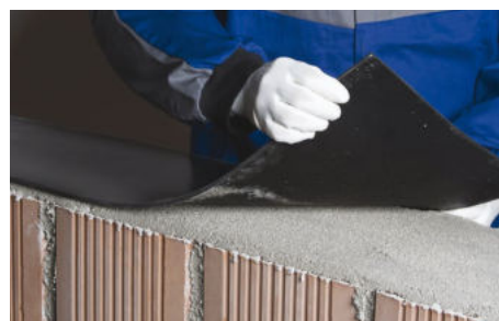
39. Flexibilná podložka na vyrovnávacej vrstve
