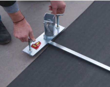
6. Nastavenie úrovne na nivelačnom sete
