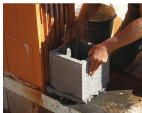
9. Umiestnenie prvej debniacej tvárnice
