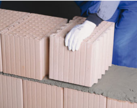
3. Vloženie murovacieho prvku do maltového lôžka
