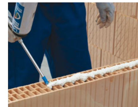
24. Naniesenie univerzálného lepidla LeierFIX na strednú drážku priečkovky
