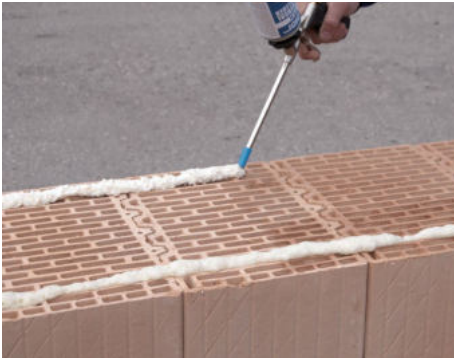
15. Nanesenie univerzálného lepidla LeierFIX 5 – 6 cm od okrajov
