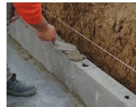
3. Nanesenie maltovej vrstvy
