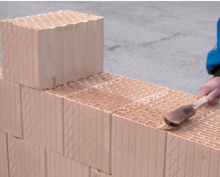
13. Navlhčenie murovacieho prvku LeierPLAN pred lepením
