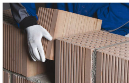
37. Umiestnenie rezaného prvku do protihlukovej steny
